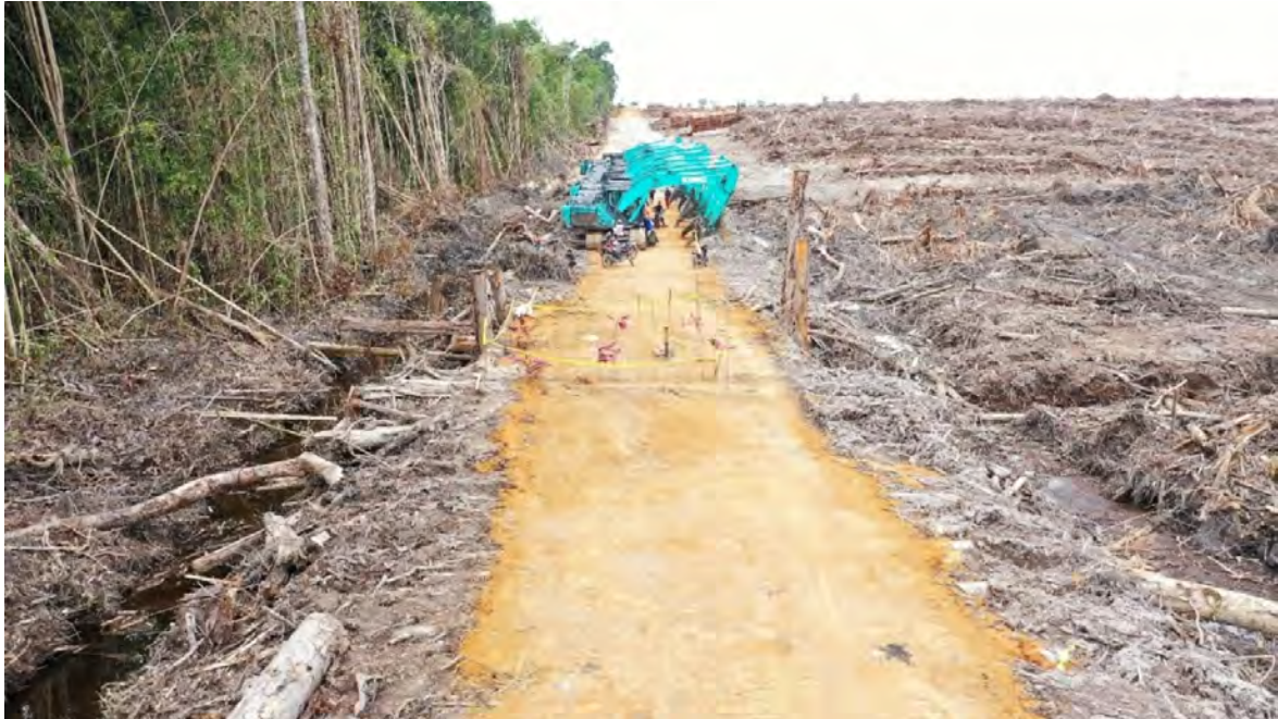
Gambar 15. Pemasangan “Mandoh Adat” dan Penahanan Alat Berat
